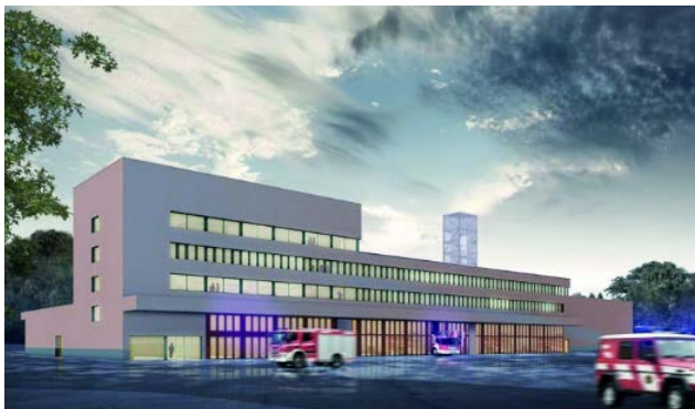
Neubau Feuerwehrstützpunkt Bern Forsthaus West
